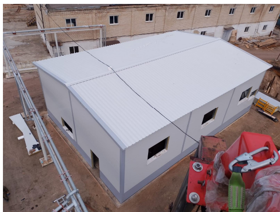
Рис. 4. Этапы быстрого возведения экологичного здания 12 x 18 м, по заказу РЖД, г. Сызрань Самарская область, ноябрь 2024 г.
