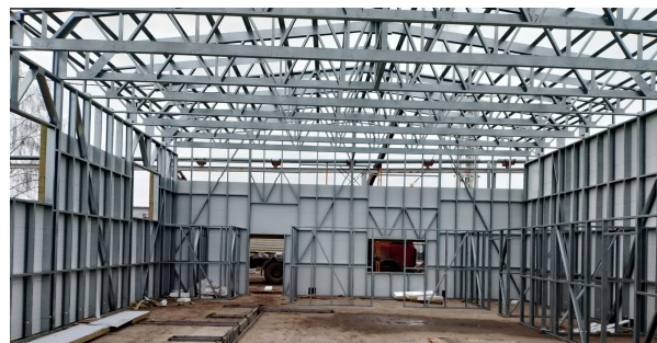
Рис. 3. Этапы быстрого возведения экологичного здания 12 х 18 м, по заказу РЖД, г. Сызрань Самарская область, ноябрь 2024 г.
