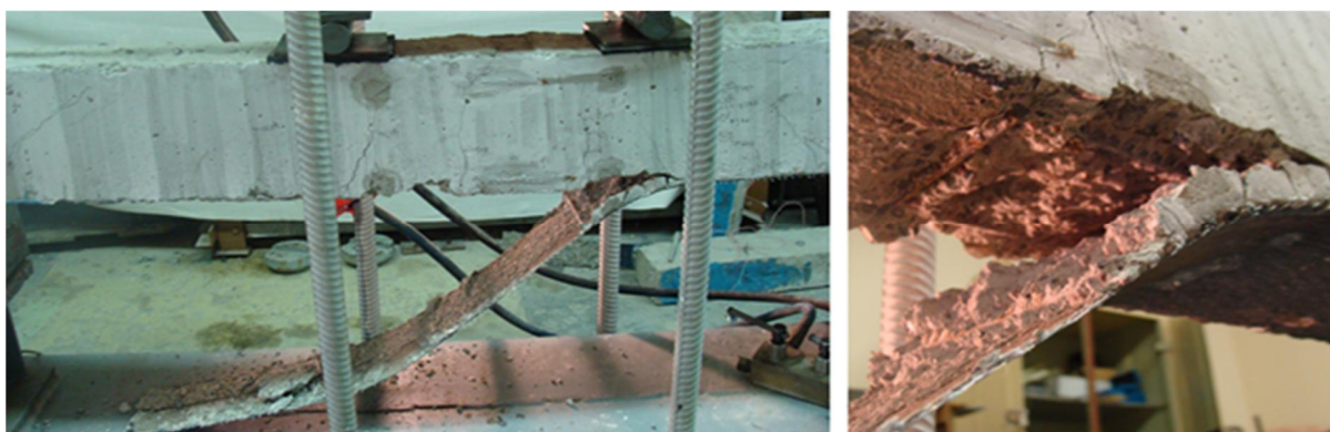
Рис. 2. Разрушение опытного образца с отслоением элемента внешнего армирования и с разрушением бетона вблизи клеевого шва
