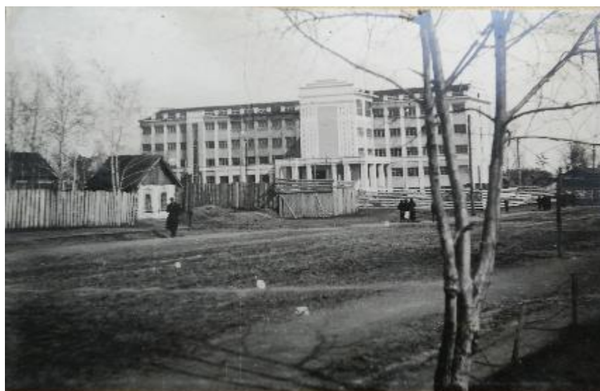
Общий вид главного учебного корпуса Сибстрина в 1934 году (год создания кафедры «Основания и фундаменты»)
