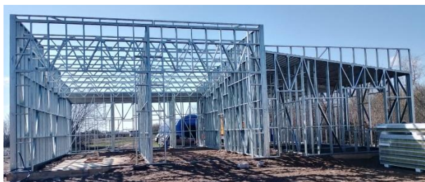
Рисунок 2 – Этапы возведения здания пожарного депо, с. Троицкое, Оренбургская область из быстро возводимых строительных систем высокой заводской готовности
