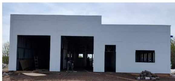
Рисунок 3 – Этапы возведения здания пожарного депо, с. Троицкое, Оренбургская область, из быстро возводимых строительных систем высокой заводской готовности. Модульные сборные элементы фасада здания
