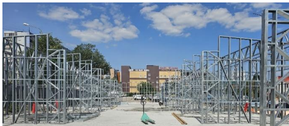
Рисунок 4 – Этапы возведения здания многопостовой мойки автомобилей в г. Самара из быстро возводимых модульных строительных систем высокой заводской готовности
