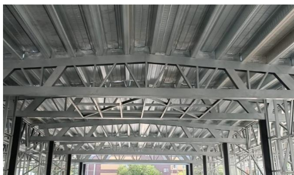
Рисунок 5 – Этапы возведения здания многопостовой мойки автомобилей в г. Самара из быстро возводимых модульных строительных систем высокой заводской готовности
