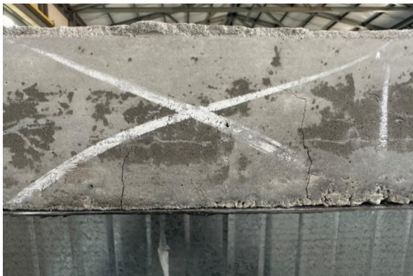
Рис. 11. Образование новой вертикальной трещины до сжатой зоны бетона с последующем развитием в горизонтальном направлении в процессе нагружения до 3182 кг/м 2
