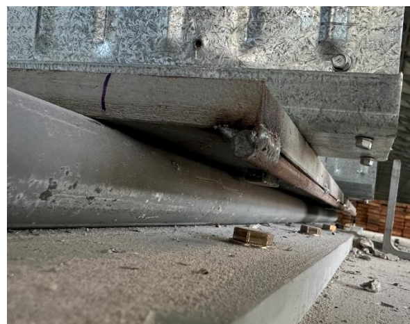
Рис. 5. Опирание профилированного настила на шарнирно-подвижную опору стенда
