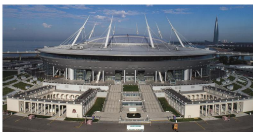
г. Санкт Петербург – 2017 Стадион «Зенит»
