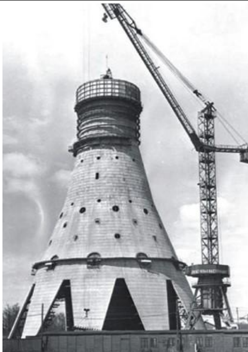
Фото из открытых источников, возведение Останкинской башни
