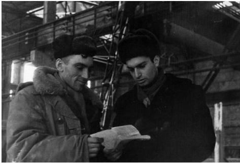
Фото из открытых источников: https://tatlin.ru/articles/mne_povezlo г. Темиртау – 1960-е. На строительстве металлургического комбината («Казахстанской Магнитки»)
